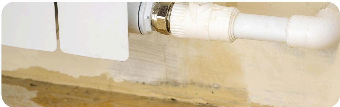
Если делать соединения в трубах некачественно и неправильно, то они будут течь, плитка взбухнет, и ее придется демонтировать, искать источник течи. Дом может быть полностью залит.
